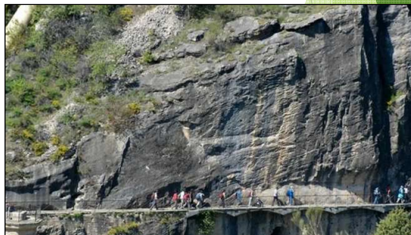
► Pasarela patones - CYII
